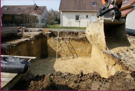
Durant cette étape, une source passe sous la maison, un puits est alors réalisé à 3m de profondeur pour pouvoir drainer l'eau montante et assurer une hors sec de chantier à venir.
